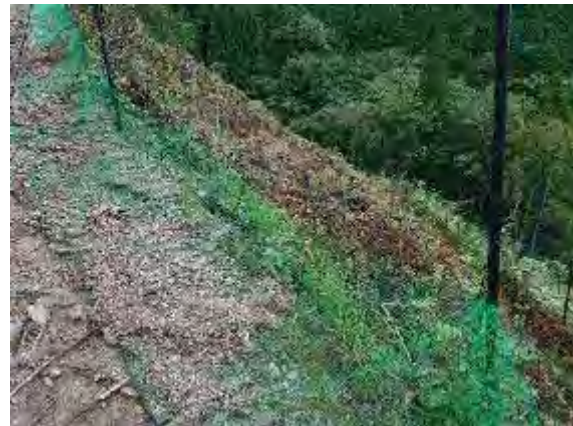
写真7. 面的防護柵の裾部分に潜り込み防止用のスカートネットを追加した例
