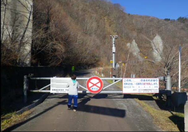
静内ダムのゲート(ゲート内工事のため監視つき)
