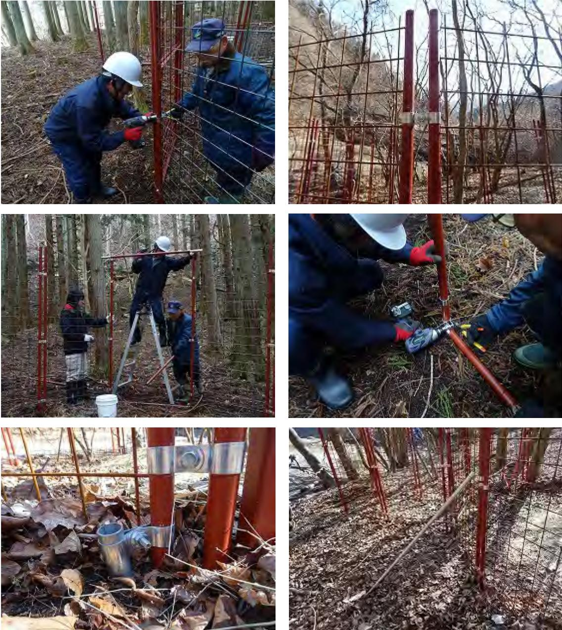
写真 5-9 簡易囲いわなの設置工程
