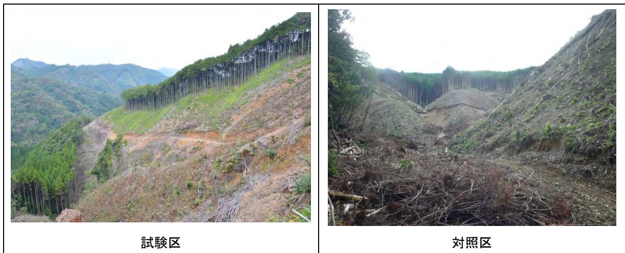
写真 4. 6. 2 試験区及び対照区の全景
