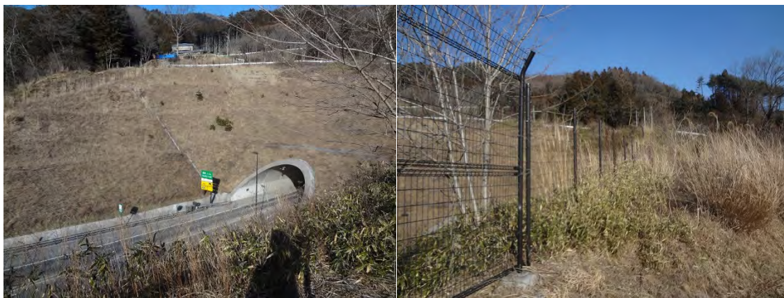
写真 6-10 通岡トンネル出口の法面
