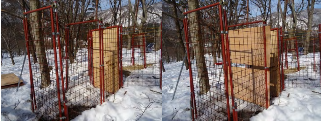
写真 6-16 仕切りの設置（左：設置前、右設置後）
