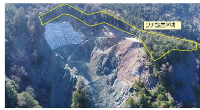
治山工事箇所周辺のワナ設置区域
