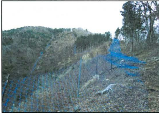
(ネット設置施工例)
