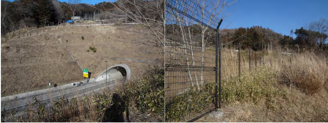
写真 6-10 通岡トンネル出口の法面
