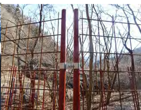
写真 5-6 ジョイント金具による連結
