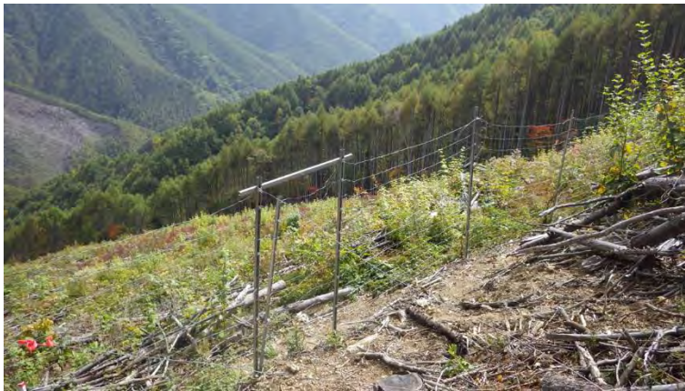
写真 3-3 皆伐地を囲うように設置された柵
