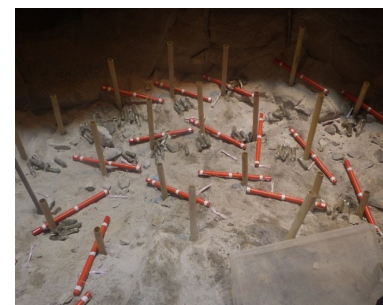
低振動かつ瞬時に破砕可能な非火薬岩石破砕工により労働者の安全を確保
