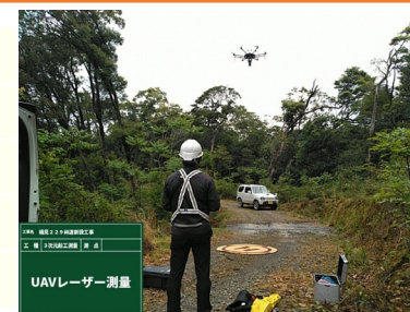
UAVレーザにより起工測量し、省力化を実現。
