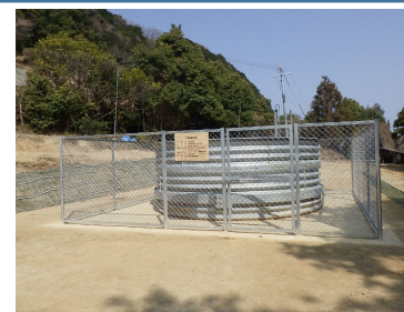
完成写真（掘削が深く危険度が高い施工条件の中、適確な施工管理、工程管理により、安全かつ丁寧に施工）
