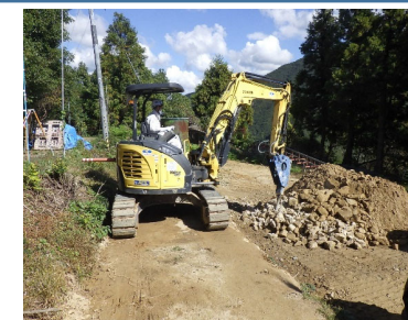
掘削した土石を混合し空隙を少なくすることで現地発生土の運搬回数を軽減
