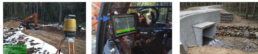
自動追尾式トータルステーションを活用したICT建設機械による施工
