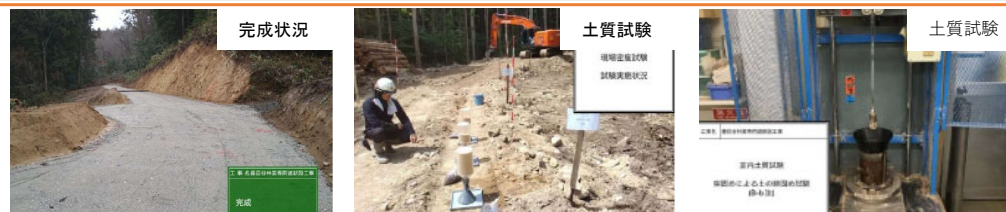
適切な施工管理、工程管理により安全かつ丁寧に施工
