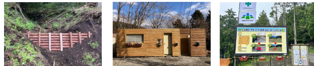
土砂流出対策や現場事務所に丸太を使用
