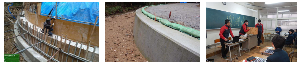
支保工を増やし、滑らかな曲線に仕上げた擁壁
