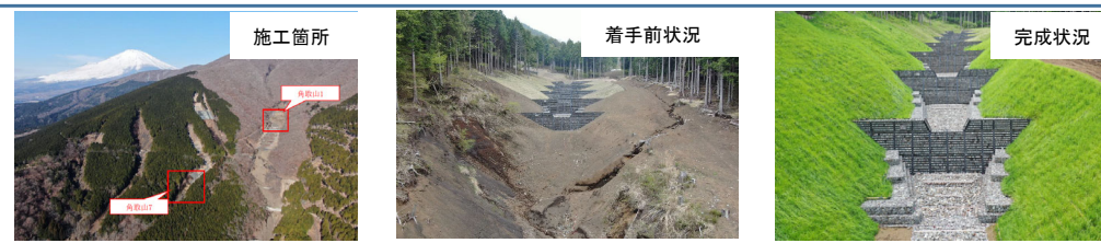
事業量が多い工事であったが、適切な施工管理、工程管理により安全かつ丁寧に施工
