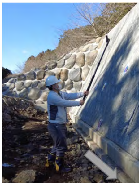
写真 4-5 自撮り棒を活用した高所の計測状況 (静岡県ホームページより)
