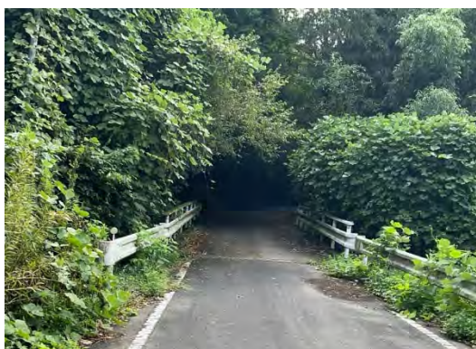
写真 4-6 上空が閉じている橋梁の状況
