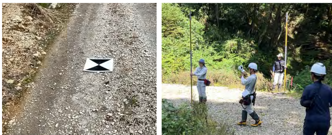
写真 5-1 Lidar_SLAM の標定点に使用する標識の例
