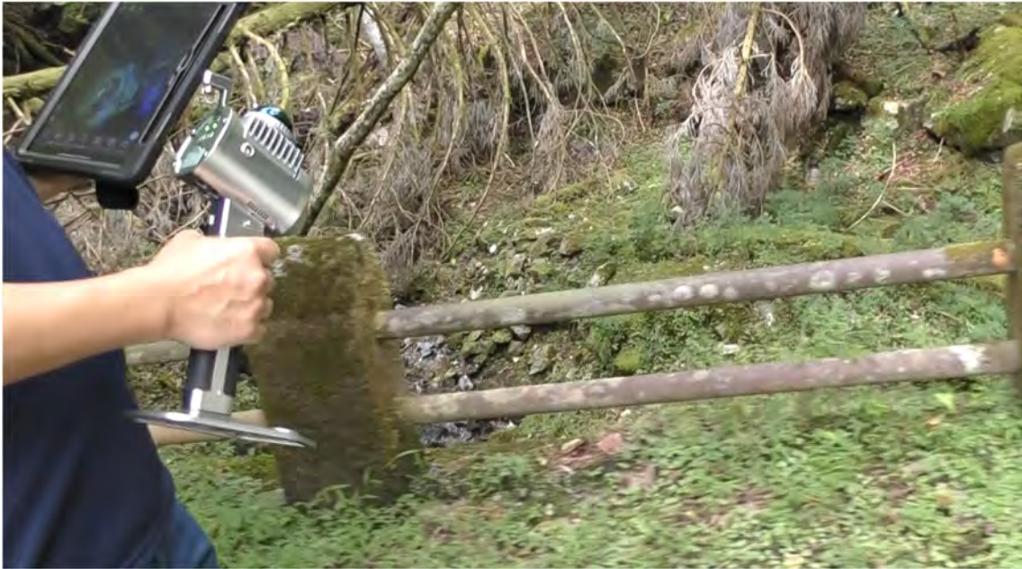
写真 3-12 LiGripO1lite による測量実施状況
