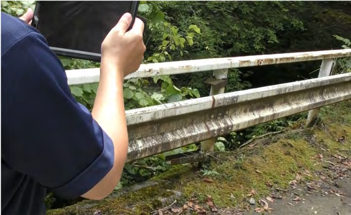
写真 3-7 Pix4DCatch による測量実施状況
