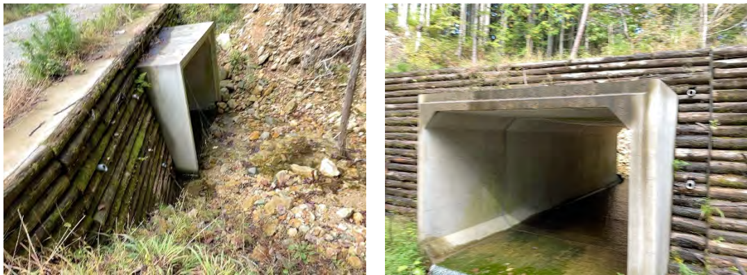
写真 4-1 ボックスカルバートの設置状況 (左：上流側、右：下流側)
