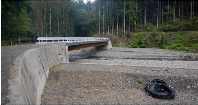
写真 5-1 桑乃川橋の全景
