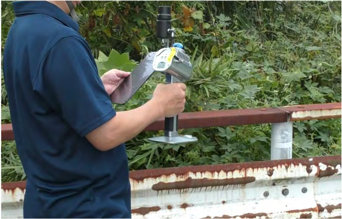
写真 3-3 Pix4DCatch による測量実施状況
