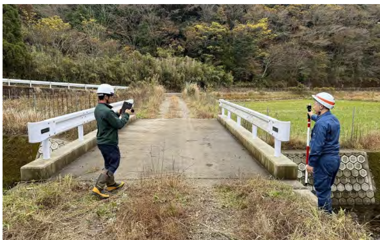
写真 5-4 Scaniverse の測量状況
