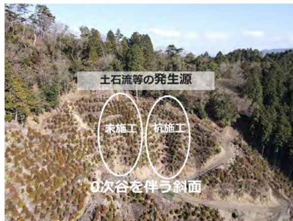
写真-4 試験施工地
