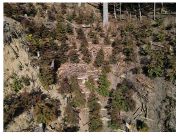
写真-5 施工後の様子
