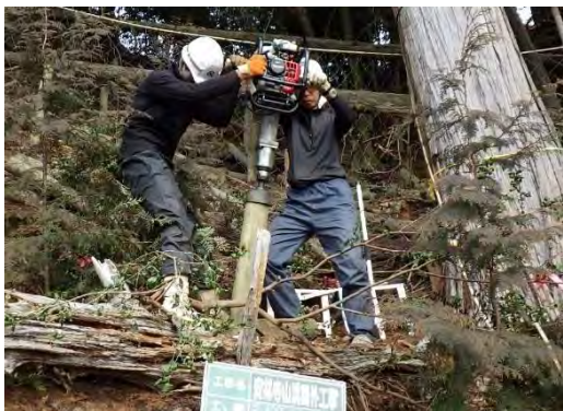
写真-2 木杭の打設
