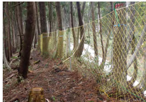
写真-7 立木使用の設置写真
