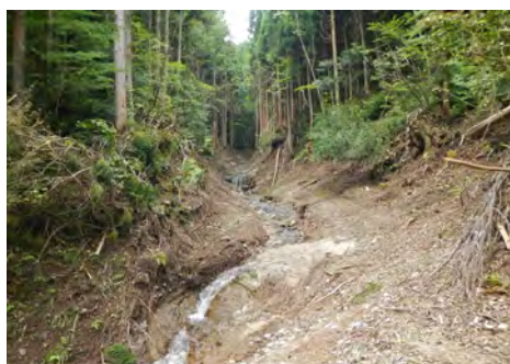
写真－3 溪岸浸食
