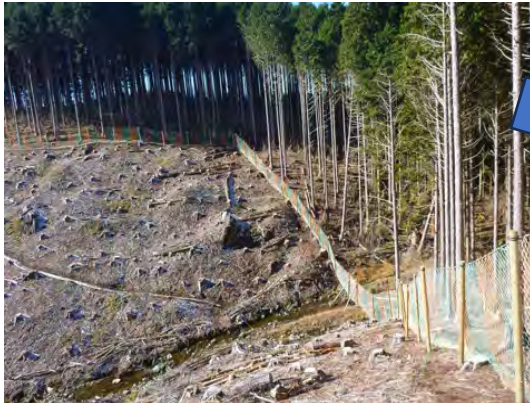
写真 2 平成 29 年 11 月 完成
