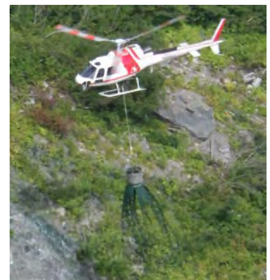
【写真4】緑化資材散布状況
