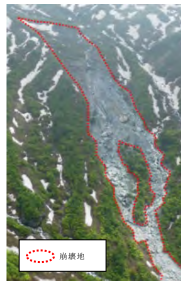
【写真1】崩壊地全景
