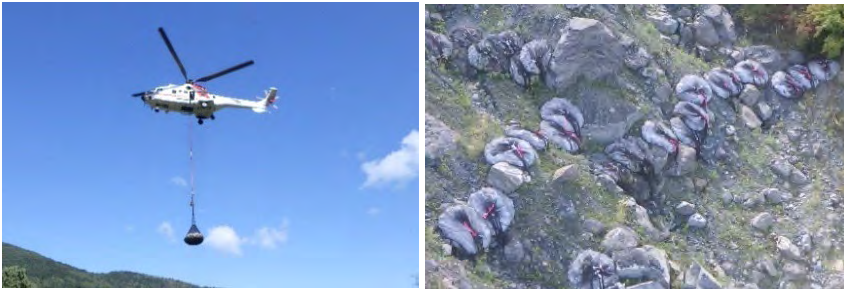
【写真7】袋型石詰筋工設置状況
