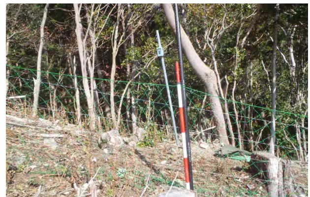
写真3 安価なネットでの施工
