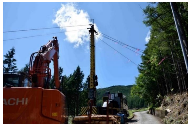
（タワーヤード集材）
