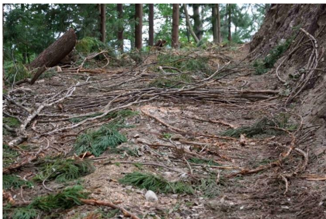
（土質が軟弱なため枝条を敷き詰めた路網）
