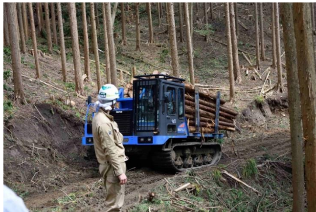
(フォワーダによる運材作業)
