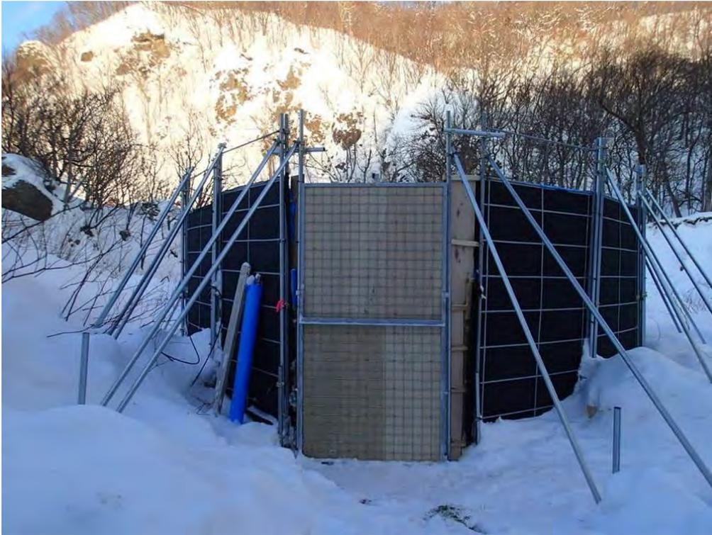
写真 8. フンベ川囲いワナの改良型落とし扉の設置完成.
