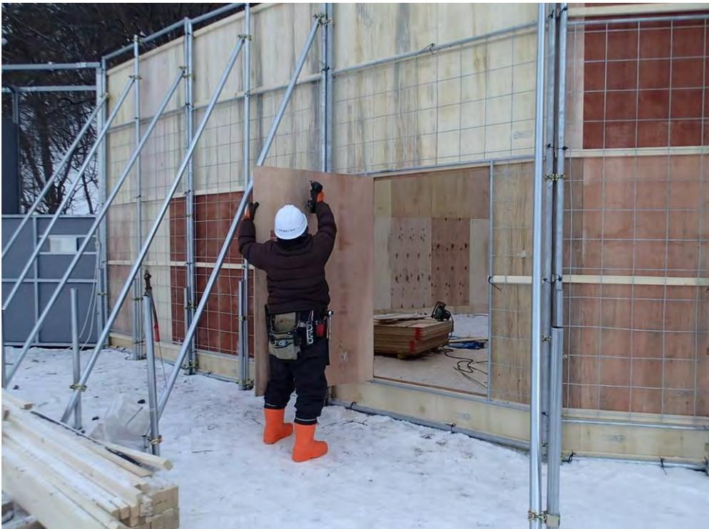
写真 15. 弁財崎囲いワナのマンゲート設置作業.
