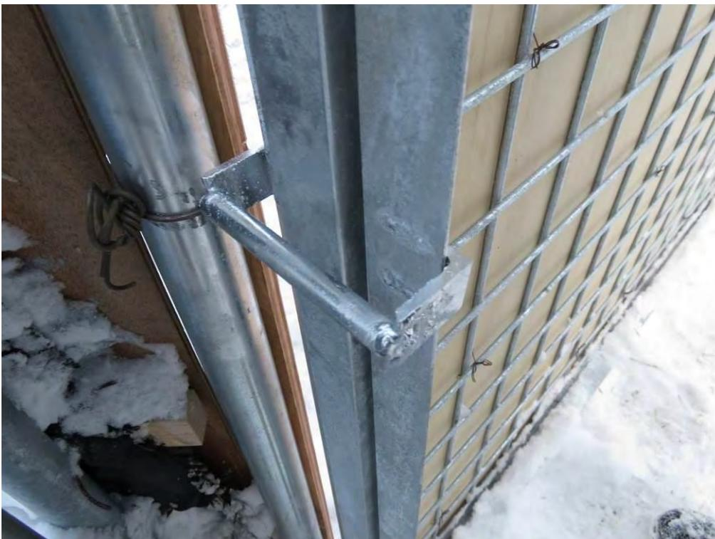
写真 9. フンベ側囲いワナの内側部材と外側部材の溶接部.
