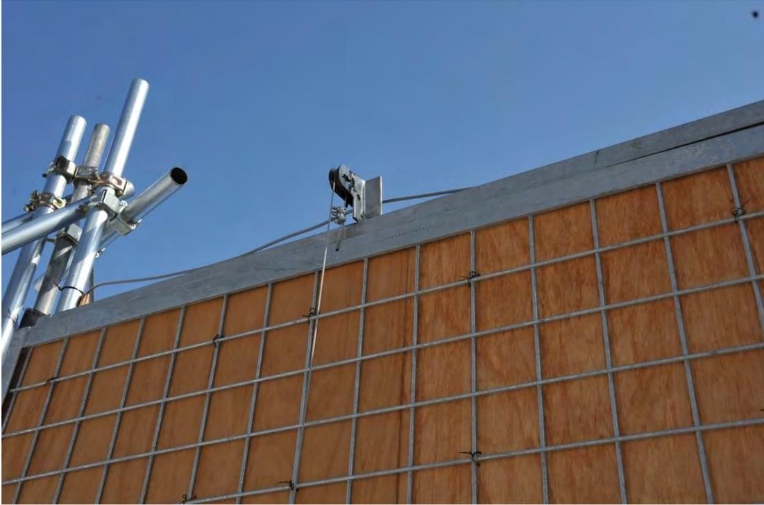
写真 10. フンベ川囲いワナの落とし扉枠（内側）上部に溶接した滑車.
