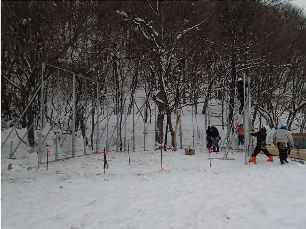
写真 12. 弁財崎囲いワナの建枠パネル、落とし扉部の設置作業風景.
