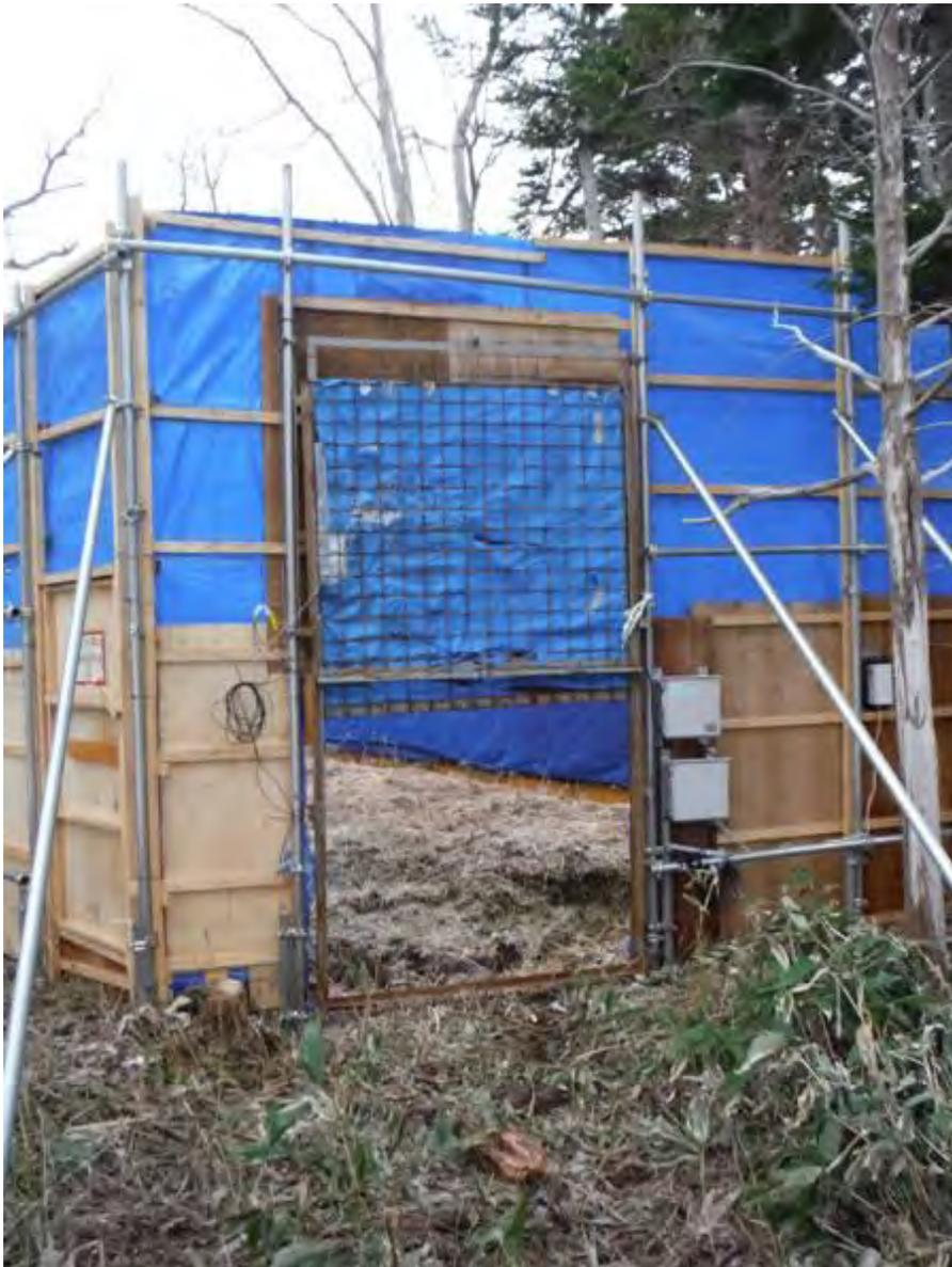
写真 1. 改良工事による移設後の自動捕獲装置用落とし扉の外観.
