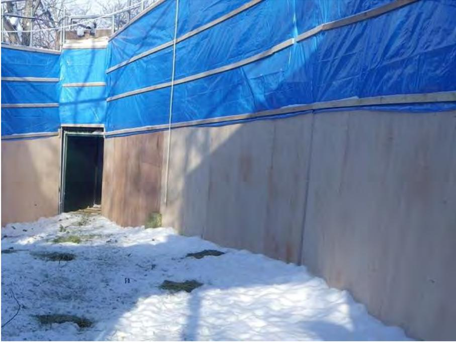
写真 8. 囲いワナの内観. 内壁はコンパネ及びブルーシートで隙間を埋め、補強された状態. 左は追い込み捕獲箱への入り口.
