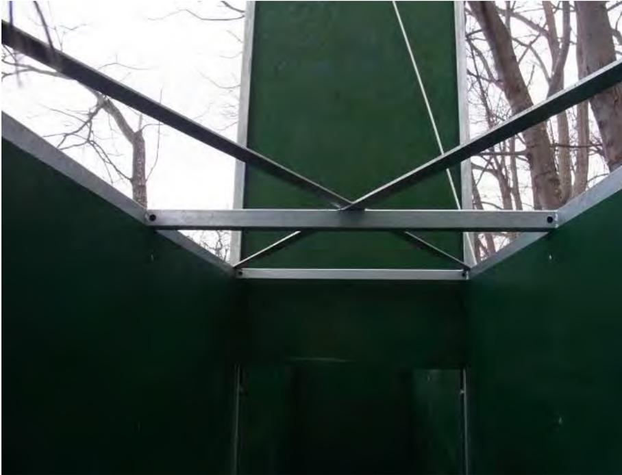
写真 6. 追い込み捕獲箱に天井がなく、捕獲したエゾシカが飛び出す恐れがある.
