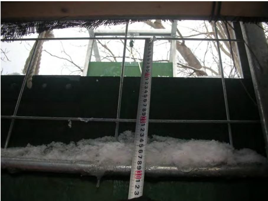
写真 7. 落とし扉の溶接金網の格子の間隔が 20 cm 四方となっており、捕獲したエゾシカが首を突っ込む恐れがある.
