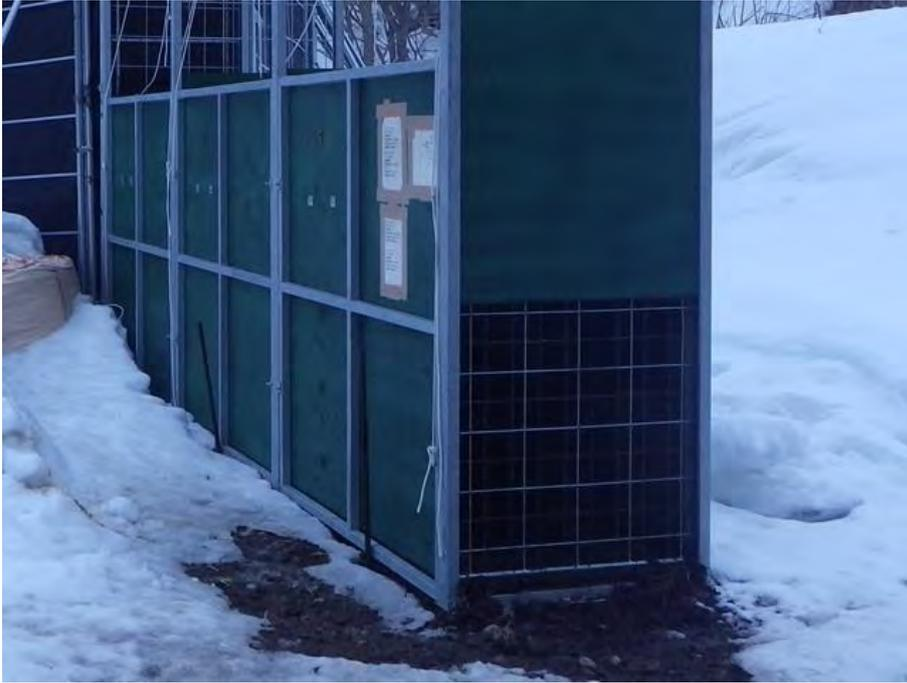
写真 10. 追い込み捕獲箱の外観。落とし扉金網は当初想定の格子幅ではエゾシカの頭部が網目に入る事故が懸念されたため、格子幅を小さめに変更した。
