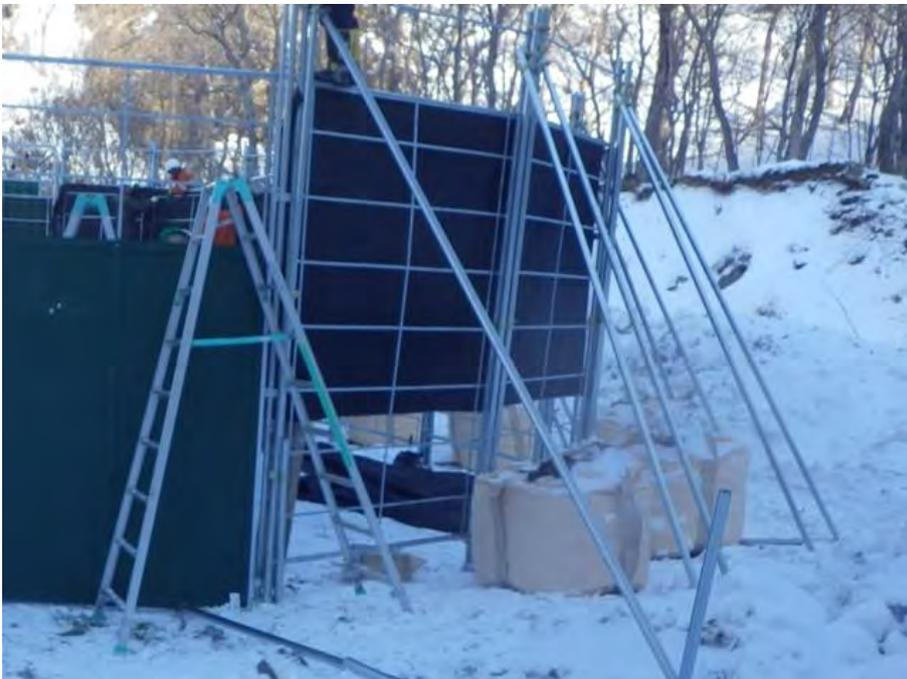
写真 11. フンベ囲いワナ作設中の外壁。鋼管を地中に埋設できないため、大型土嚢で建枠パネルを固定した。
