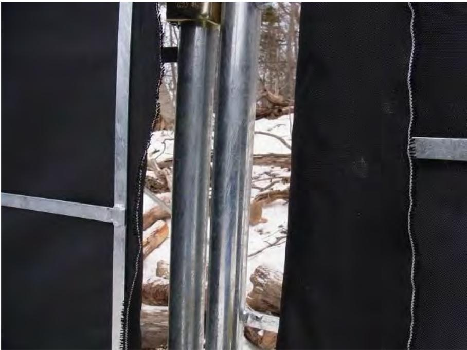
写真 5. 建枠パネルに大きな隙間ができ、捕獲したエゾシカが首を突っ込む恐れがある.
