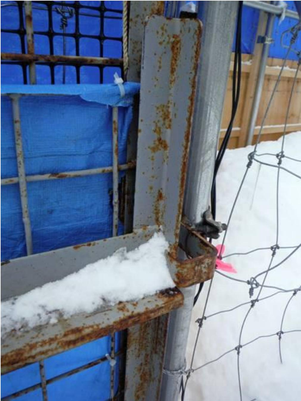
写真 5. エゾシカ捕獲用鋼製落とし扉の左右枠の状態 1（扉閉鎖時）.
