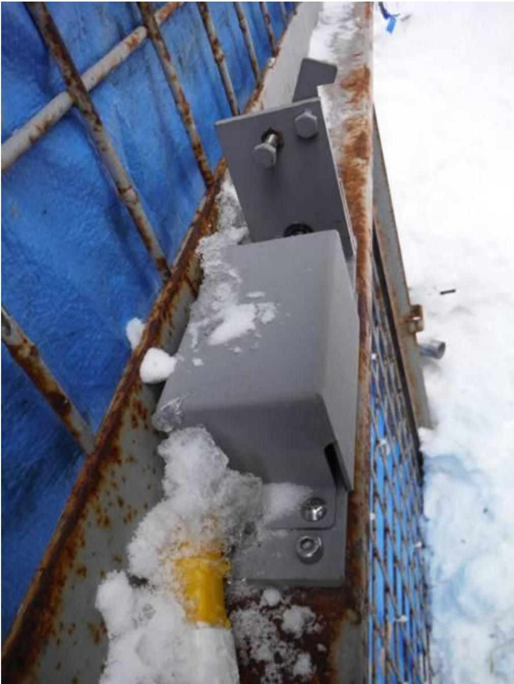
写真 9. 鋼製落とし扉の二重外枠下半分の上部に取り付けたトリガー部分の側面観（扉閉鎖時）.
