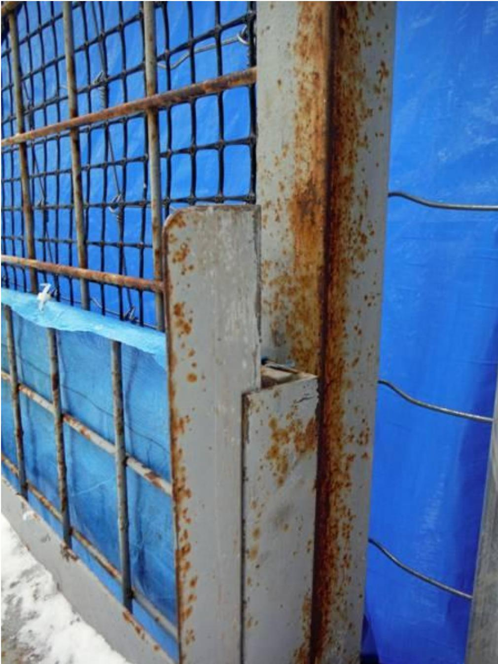
写真 6. エゾシカ捕獲用鋼製落とし扉の左右枠の状態 2 (扉閉鎖時).
