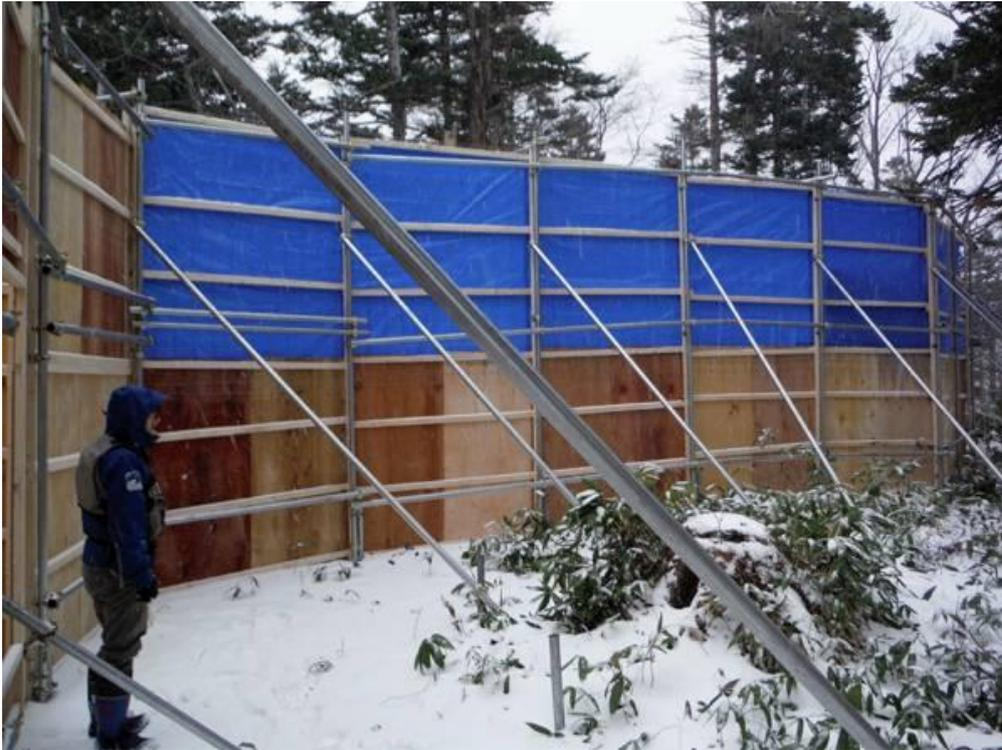
写真 2. 囲い込み部の壁面（外側観）. 下半分は縦コンパネ張り、上半分はブルーシートと金網の二重構造（作設中の写真）.
