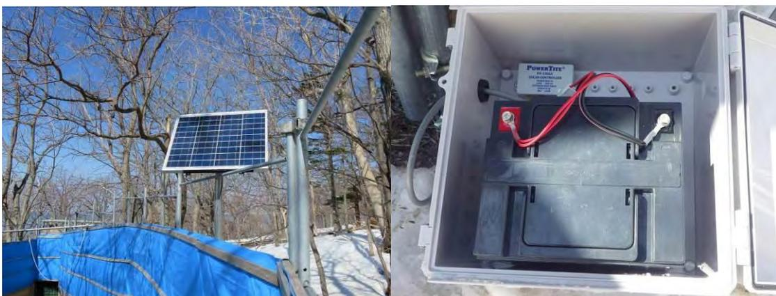
写真 22. 電源システムソーラーセット.
