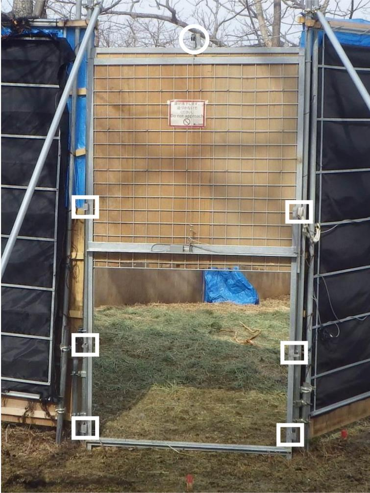
写真 6. 落とし扉枠の溶接部分 3 対計 6 か所 (□部分) と滑車部分 (上部の○部分).
