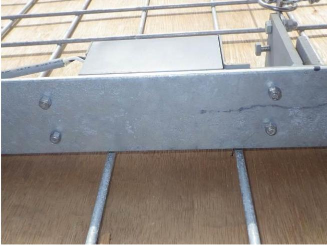
写真 8. 電子トリガー設置状況（下側より撮影）.
