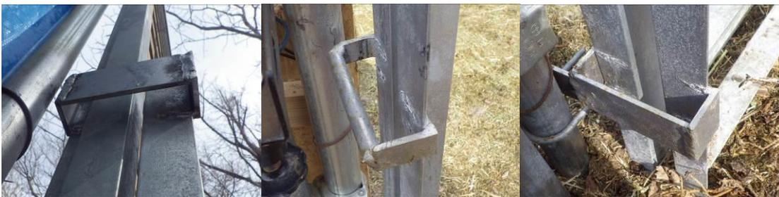
写真 7. 落とし扉枠の溶接部分 3 対の片側 (左から上・中・下).
