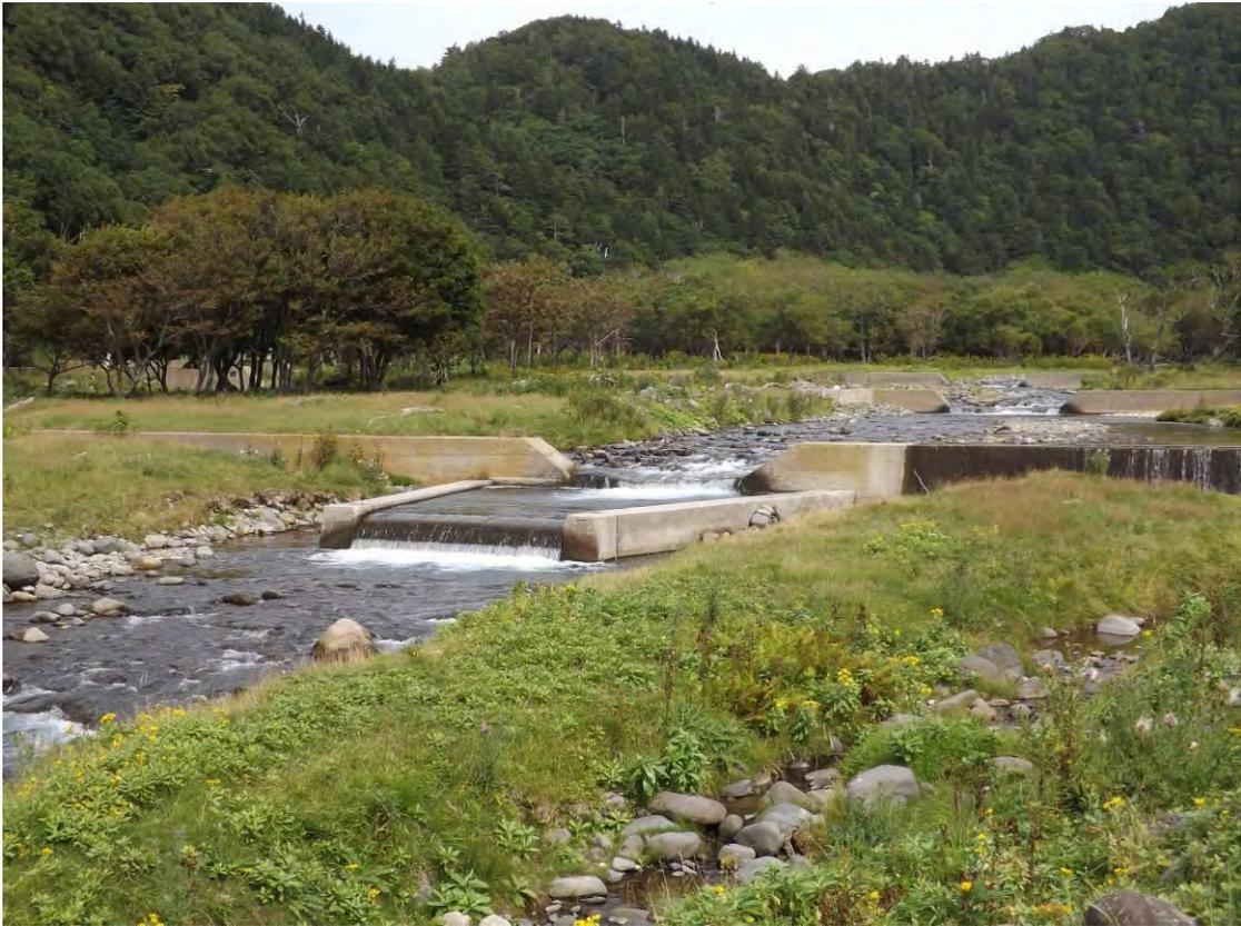
写真7. 近年になり上下流間の落差が拡大した第1ダム
