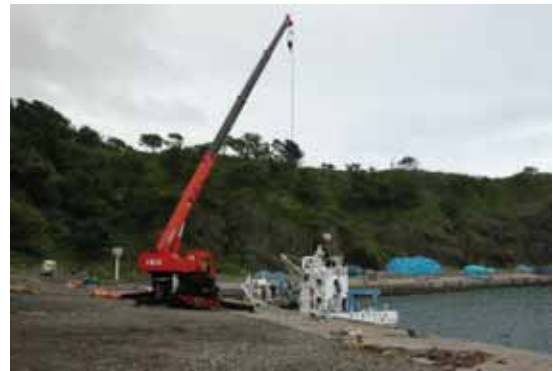
写真-10 7/2 文吉湾資材陸揚げ作業
