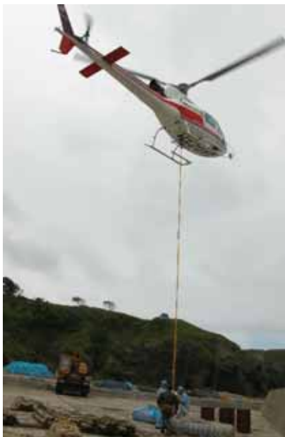
写真-11 7/2 文吉湾資材吊り上げ作業
