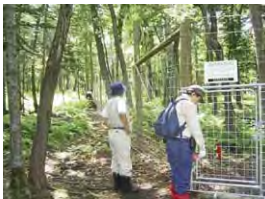
写真-13 標識取り付け作業
