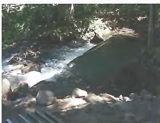
堤体部 (改良工事施工時)
