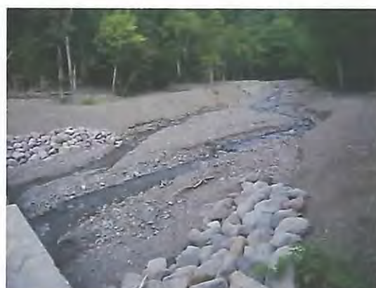
(堤体部より上流の状況)
