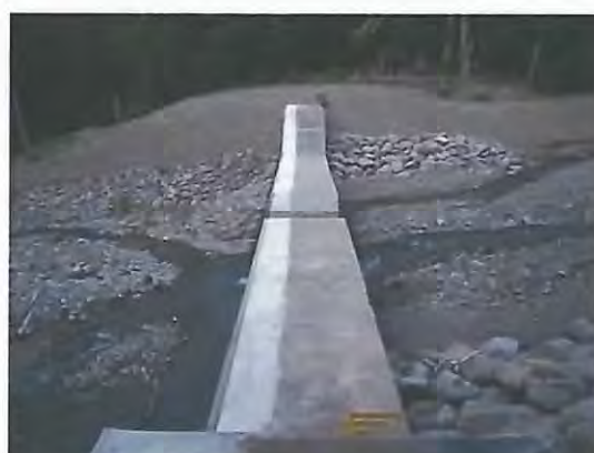
(堤体部の状況)
