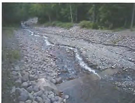
(堤体部より下流の状況)
