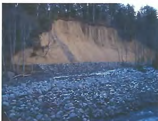
(改良後崩壊地)
