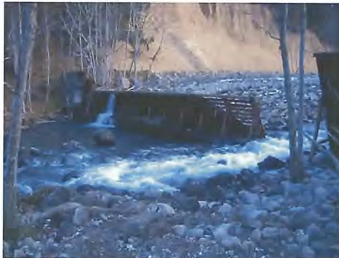
写真 4-1 赤イ川 H18 改良治山ダム (No. 11)
