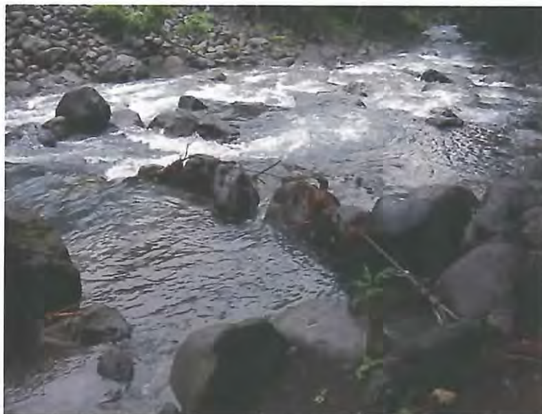
写真 3-9 露出している玉石連結工
