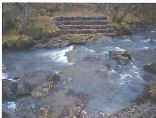
写真 3-10 孵化場導水管 横断部の状況
