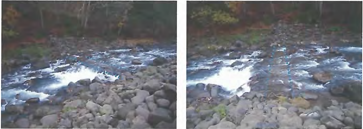
写真 3-7 赤イ川 治山ダム (No.11) の状況
