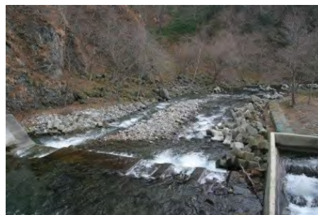
第2ダム下流の状況（改良後）
