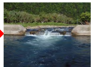
第 3 ダム改良後
