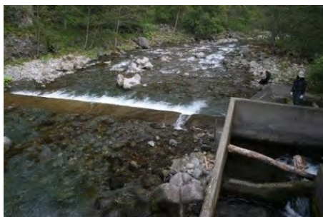
第2ダム下流の状況（改良前）
