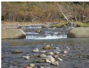
第 2 ダム改良前
