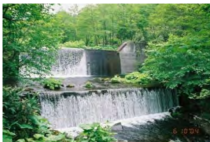
第 2 ダム改良前
