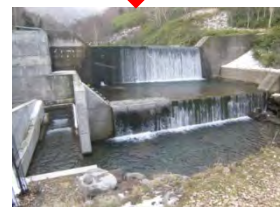
第 1 ダム副ダム再改良後
