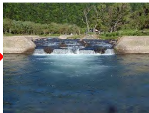
第 2 ダム改良後
