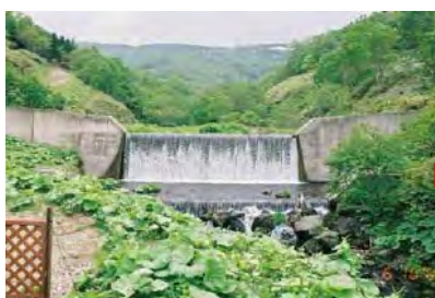
第 1 ダム改良前
