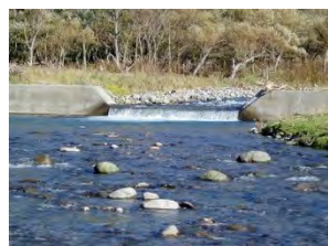
第 3 ダム改良前
