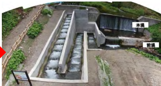
第 1 ダム改良後
