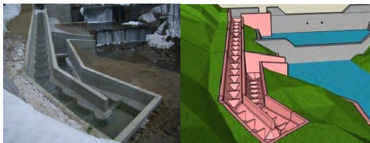
第 2 ダム改良後
