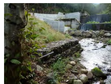
第 2 ダム下流部 (H24)
