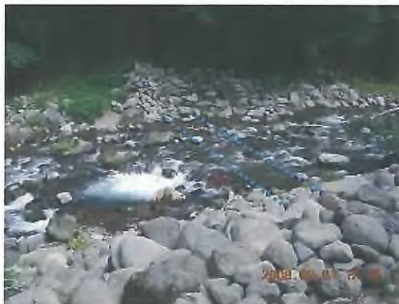
写真 3-6 赤イ川 No.11 治山ダムの状況
