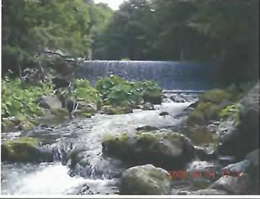
赤イ川 鋼製治山ダム(No.12)
