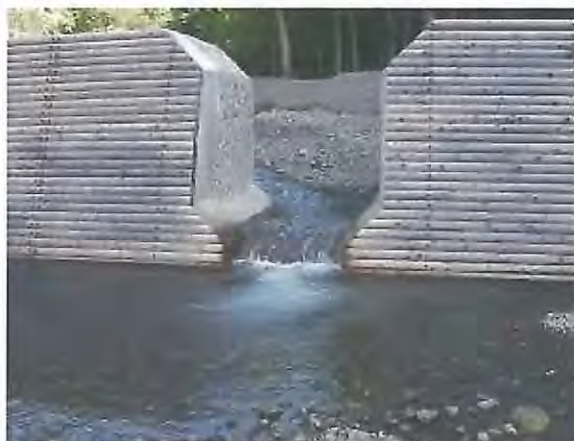
写真 4-4 改良箇所スリット部 (No. 8)
