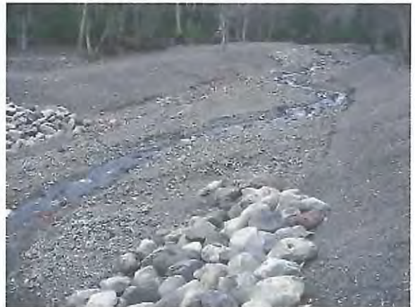
(堤体部より上流の状況)
