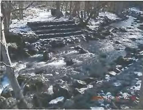
堤体前景（改良後）
