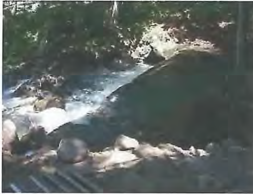
堤体部（改良工事施工時）
