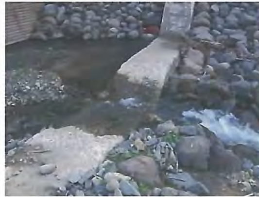
ピリカベツ川 H19改良ダム 副ダム(No.10) 堤体の越流部の状況。
