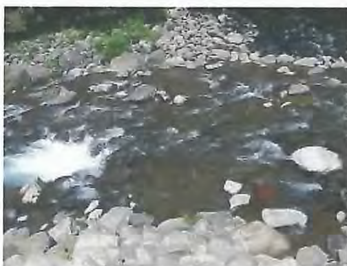
堤体越流部（左岸より撮影）
