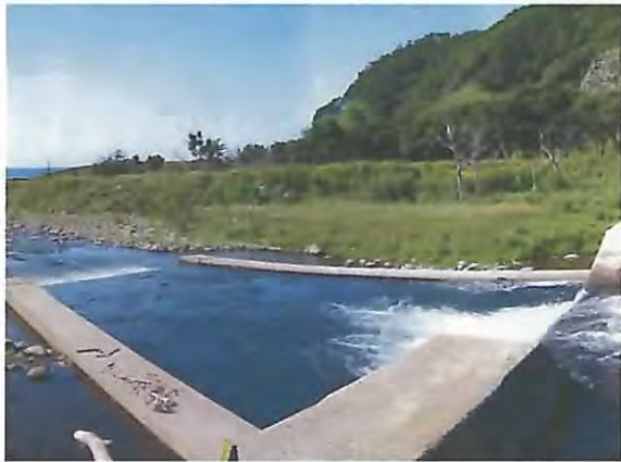
下流プール状況
