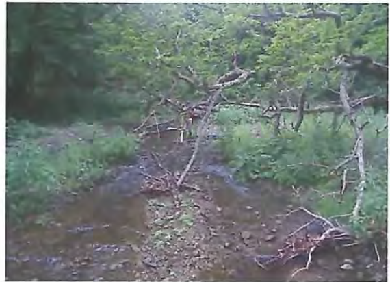
治山ダム上流部の土砂堆砂状況。
