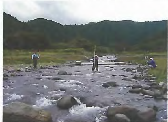
下流より望むNo.1床固工
