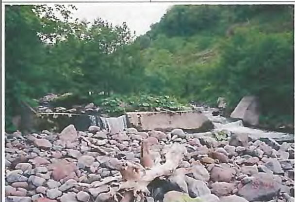
下流より望むNo.3床固工。
