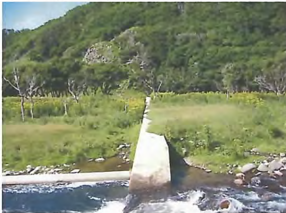
右岸河畔林状況
