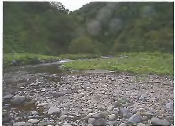
治山ダム上流の土砂堆砂状況。
