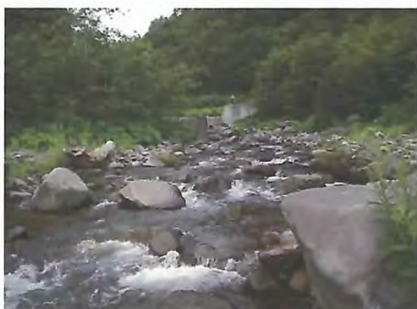
治山ダム上流部の土砂堆砂状況。
