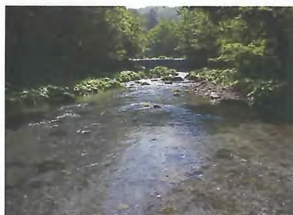
治山ダム上流部の土砂堆砂状況。
