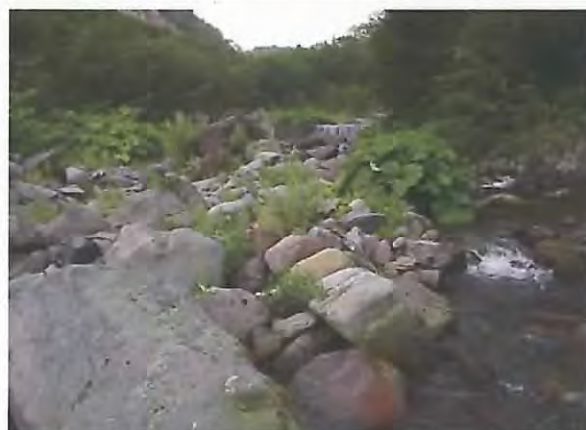
治山ダム上流部の土砂堆砂状況。
