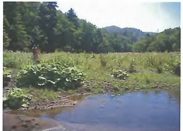
治山ダム上流部の土砂堆砂状況。
