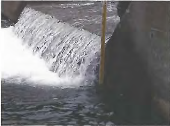
ダム放水路落差状況
