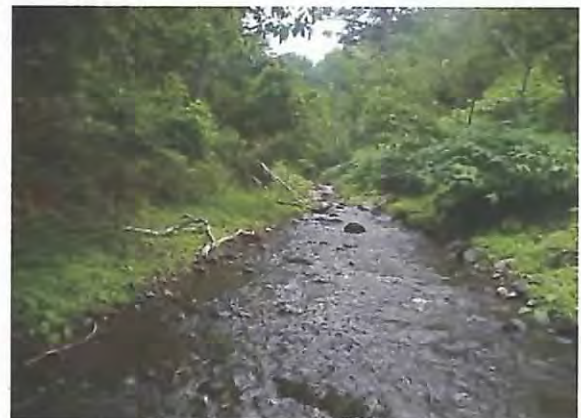
治山ダム上流部の土砂堆砂状況。
