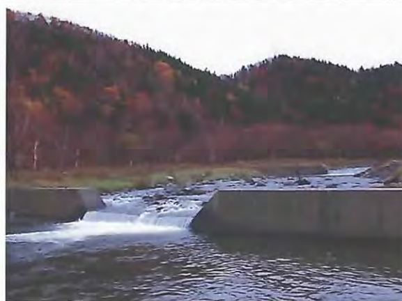
下流より望むNo.2床固工放水路
