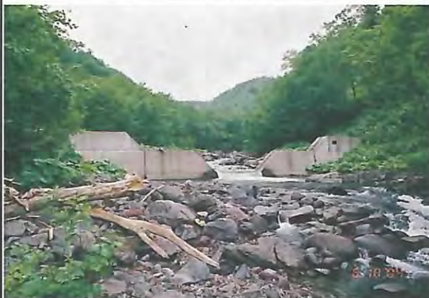
下流より望むNo.6床固工。
