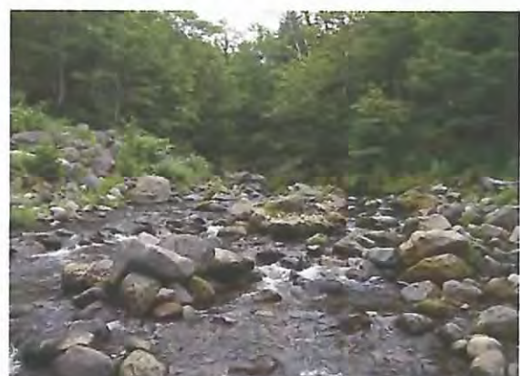
治山ダム上流部の土砂堆砂状況。
