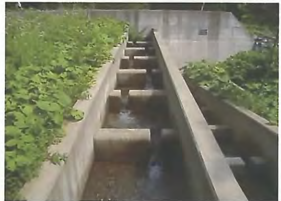
治山ダム右岸の魚道。
