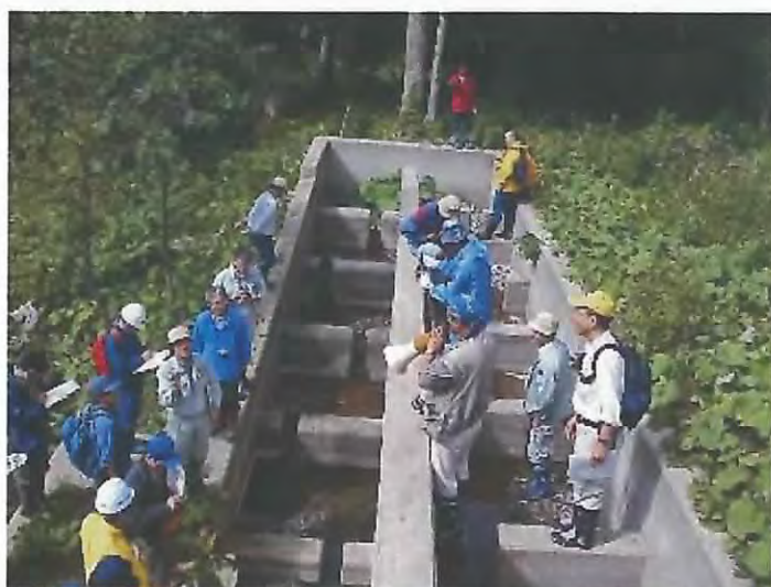
平成17年9月21日 イワウベツ川支流のピリカベツ川 No.8、10 谷止工（森林管理局）に 設置された魚道にて
