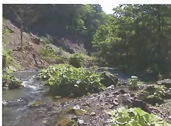
治山ダム上流部の土砂堆砂状況。
