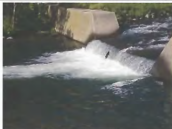
ダム放水路落差状況
