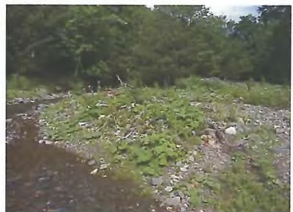
治山ダム上流部の土砂堆砂状況。
