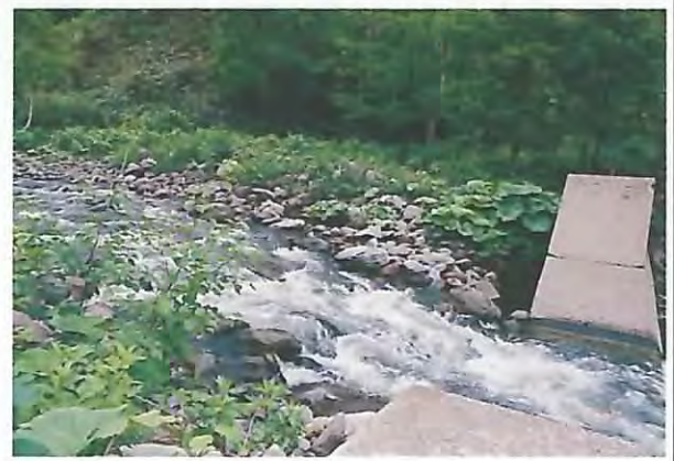
治山ダム上流部の土砂堆砂状況。
