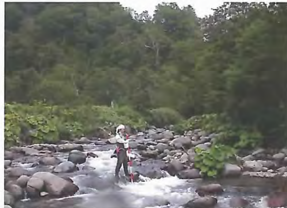
治山ダム上流の土砂堆砂状況。
