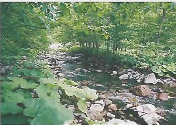
治山ダム上流部の土砂堆砂状況。
