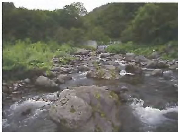
治山ダム上流部の土砂堆砂状況。
