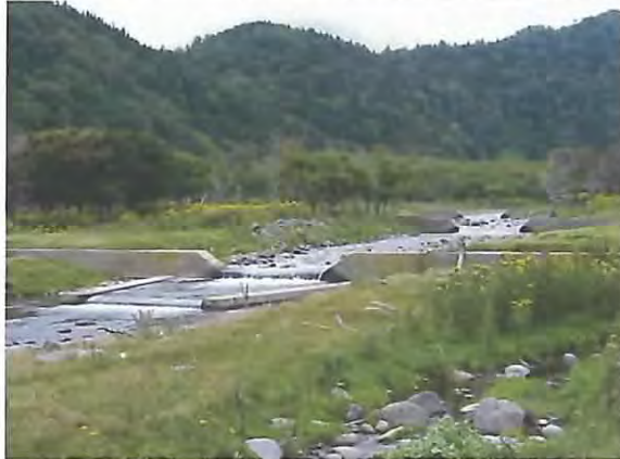
下流よりNo.1床固工全景
