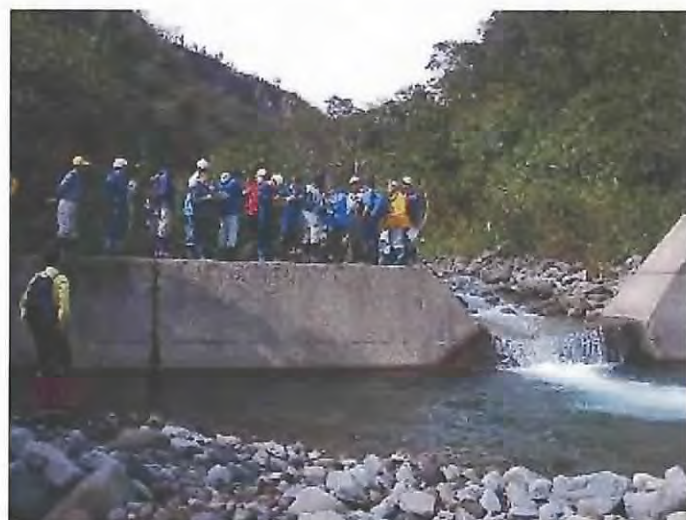
平成 17 年 9 月 22 日 モセカルベツ川 No.4 床固工（北海道）にて
