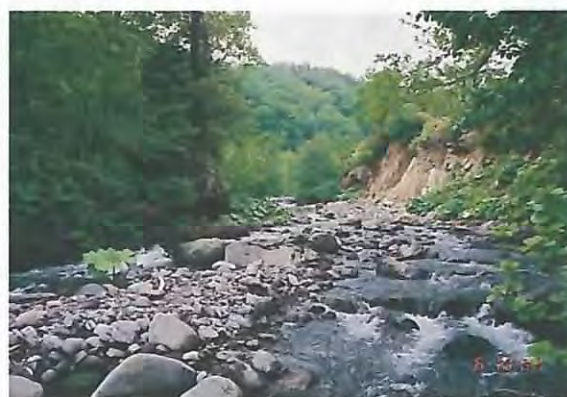
治山ダム上流部の土砂堆砂状況。
