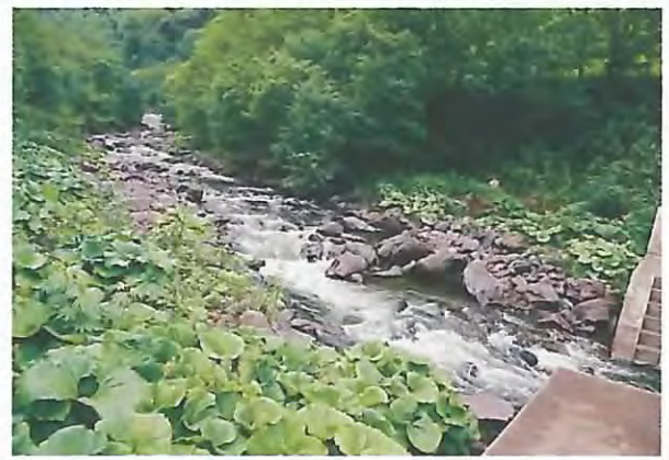
治山ダム上流部の土砂堆砂状況。
