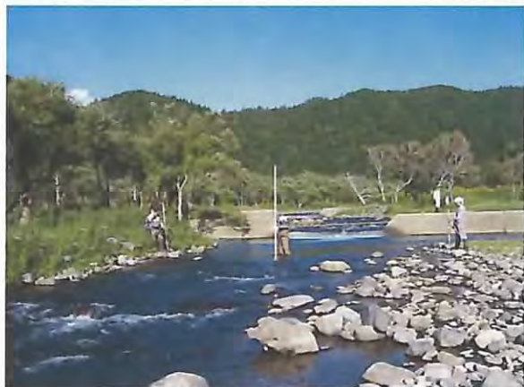
下流より望むNo.2床固工
