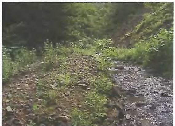
治山ダム上流部の土砂堆砂状況。
