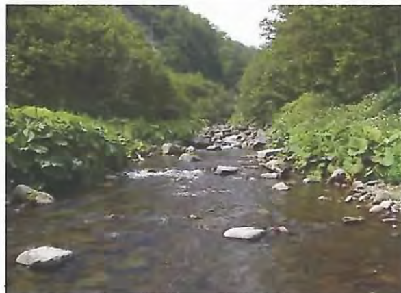
治山ダム上流部の土砂堆砂状況。
