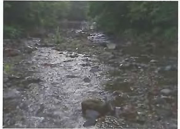
治山ダム上流部の土砂堆砂状況。
