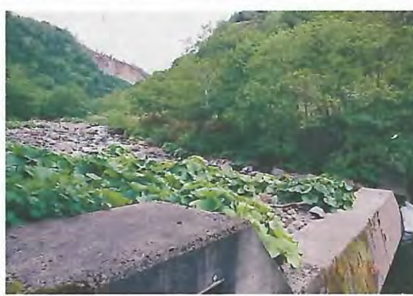
治山ダム上流部の土砂堆砂状況。
