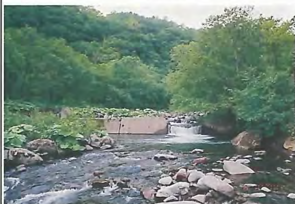
下流より望むNo.2床固工。
