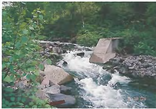
下流より望むNo.5床固工。
