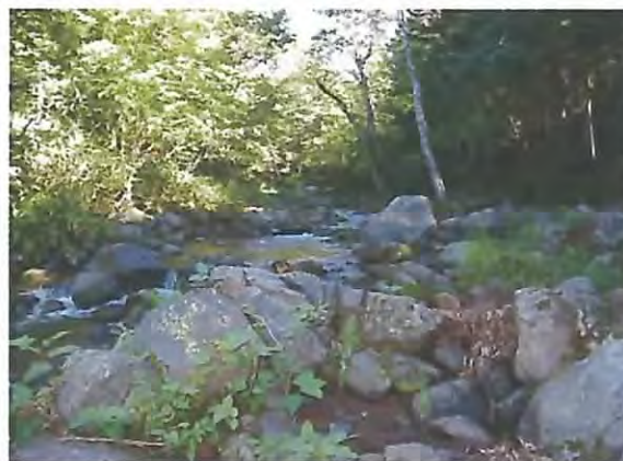
治山ダム上流部の土砂堆砂状況。
