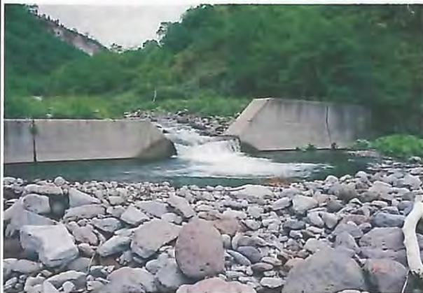
下流より望むNo.4床固工。
