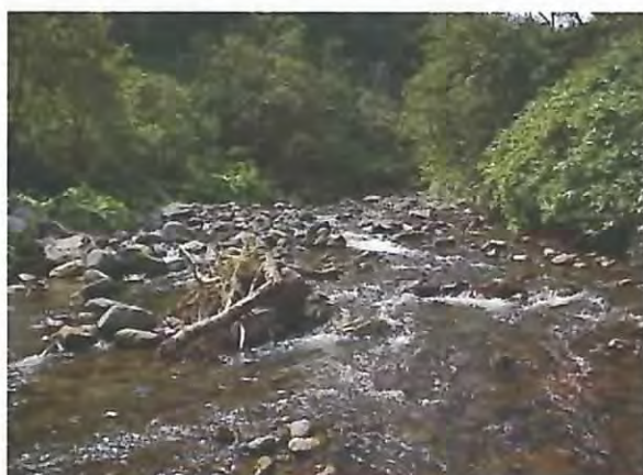
治山ダム上流部の土砂堆砂状況。
