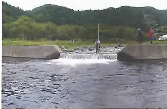
下流より望むNo.3床固工
