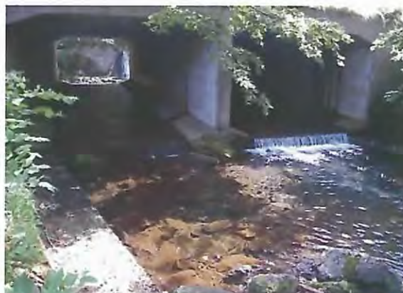
ボックスカルバートを下流より望む。
