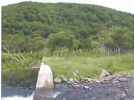
右岸河畔林状況
