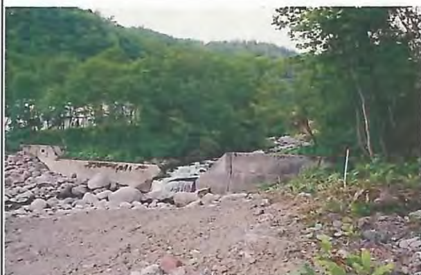
下流より望むNo.1床固工。
