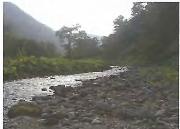
治山ダム上流の土砂堆砂状況。
