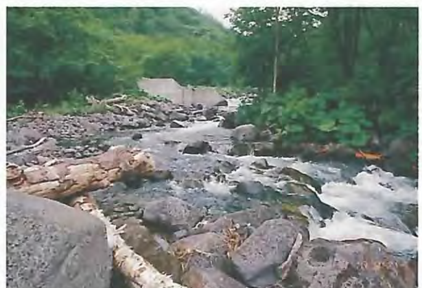
治山ダム上流部の土砂堆砂状況。
