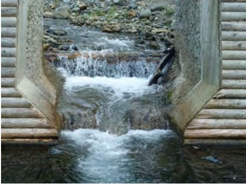
ピリカベツ川 No.8, 10 ダムのスリット部流木堆積状況 (9月25日)
