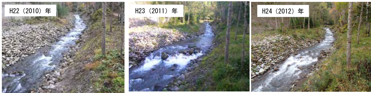
写真 6.8 SP20 (No. 12 鋼製えん堤上流部) の状況
