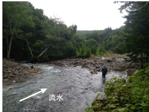
写真 6.9 DSP120 (No. 13 鋼製えん堤上流部) の状況
