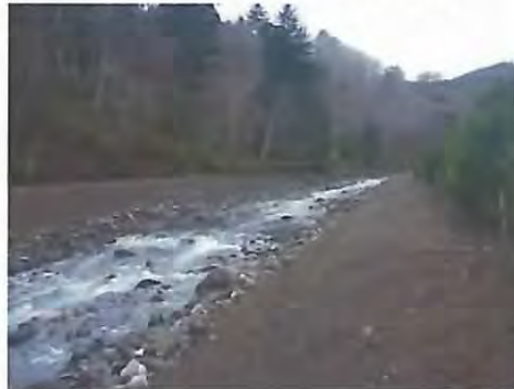
施工直後上流部の流路 (H22年11月)
