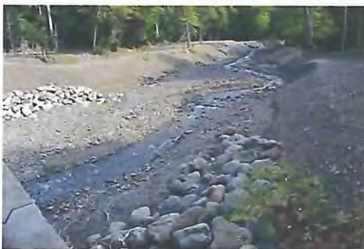
堤体上流区間：巨石連結格子枠による帯工と石張護岸による整備
