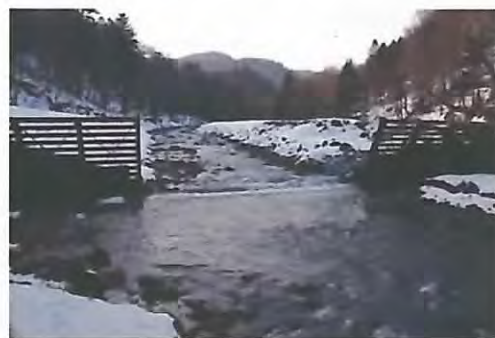
土砂流出後 (H22年12月)
