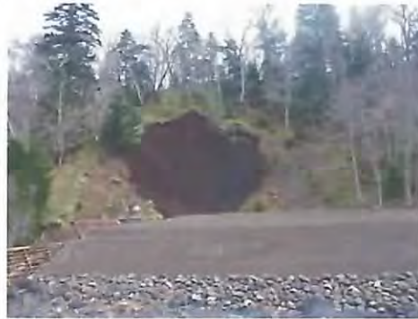
右岸の山腹法面工 (H22年10月)
