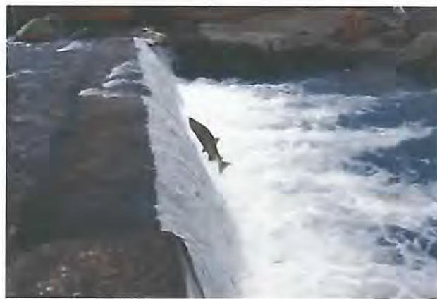
5 回目(10 月 10 日)調査時には、ふ化場捕獲施設落差工で、遡上を試みるシロザケが観察された。
