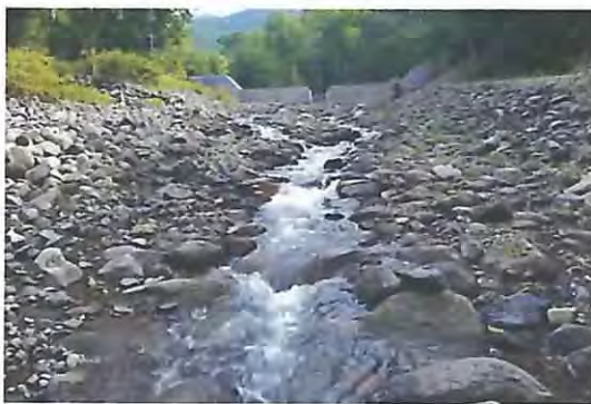
堤体下流区間：石張流路工と石張護岸による整備
