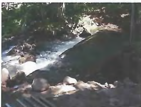
堤体部（改良工事施工前）
