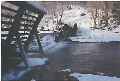
左岸部土砂流出による上流の流路変化 (H22年12月)
