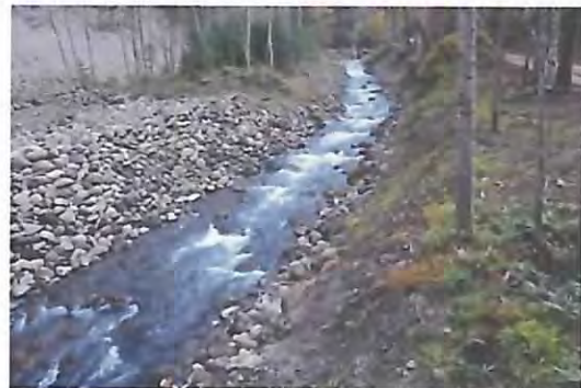
上流側の流路 (H22 年 10 月)
