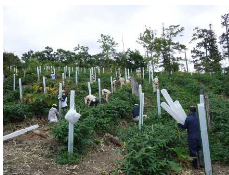
▽保護管被覆の様子
