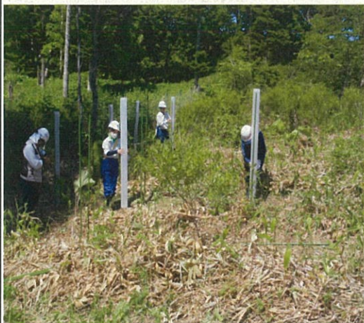
▽保護管設置の様子
