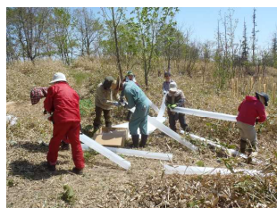
▽保護管の組立ての様子
