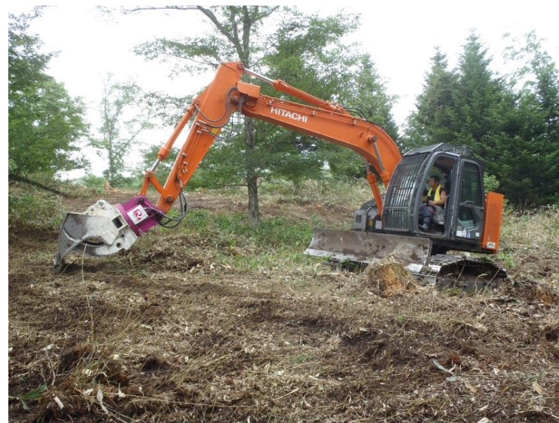
大型機械による地表処理
