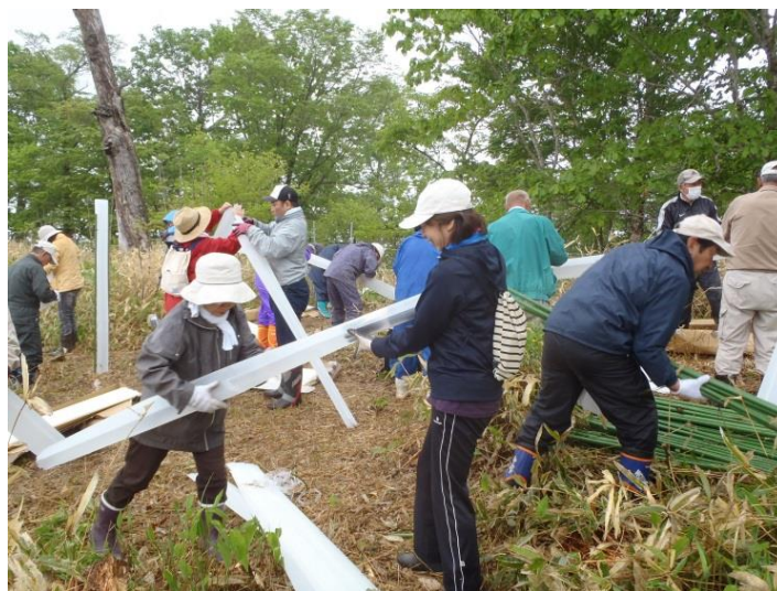
地域住民による保護管組立て作業の様子
