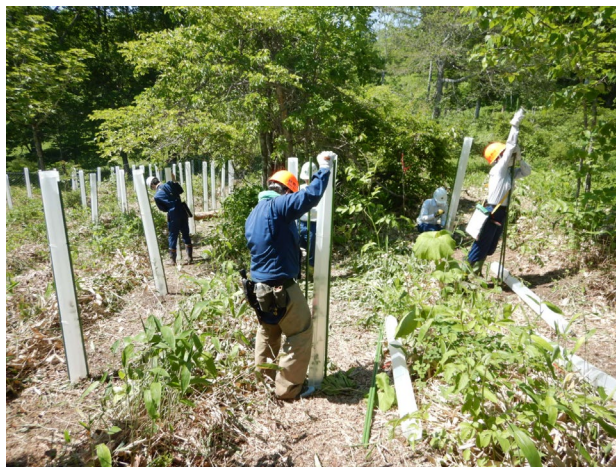
保護管被覆の様子 (笹地11・職員のOJT)
