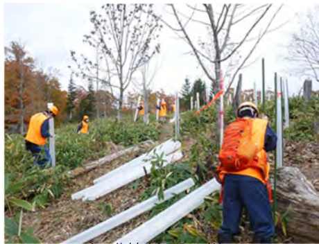
保護管被覆の様子
