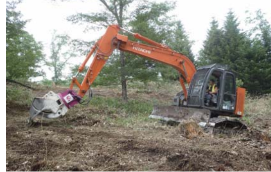
大型機械による地表処理
