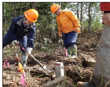
境界標埋めは人力作業です
