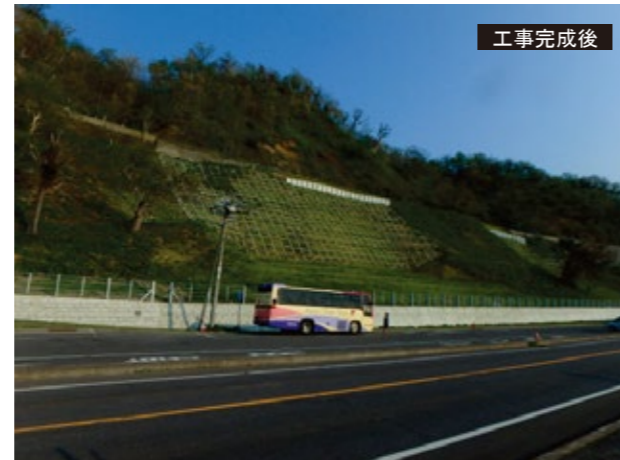
治山工事により復旧した法面
