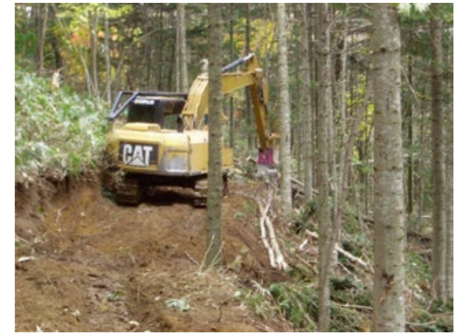
バックホウによる森林作業道の作設
