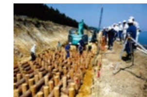
●木柱を用いた土木工事
