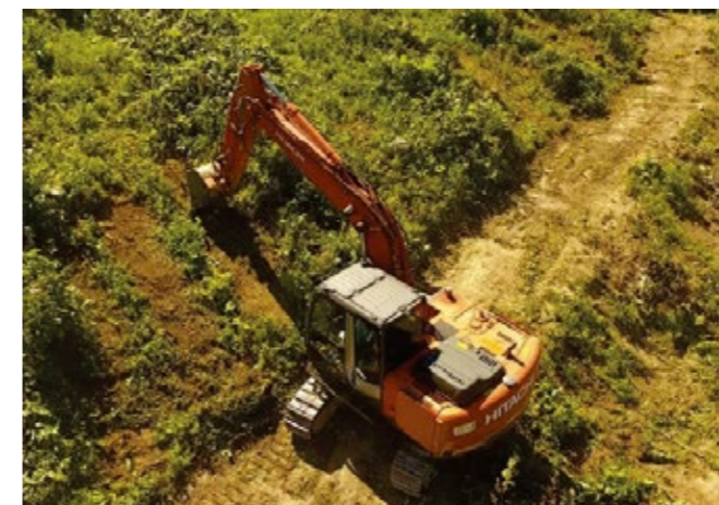
大型機械による地拵え
