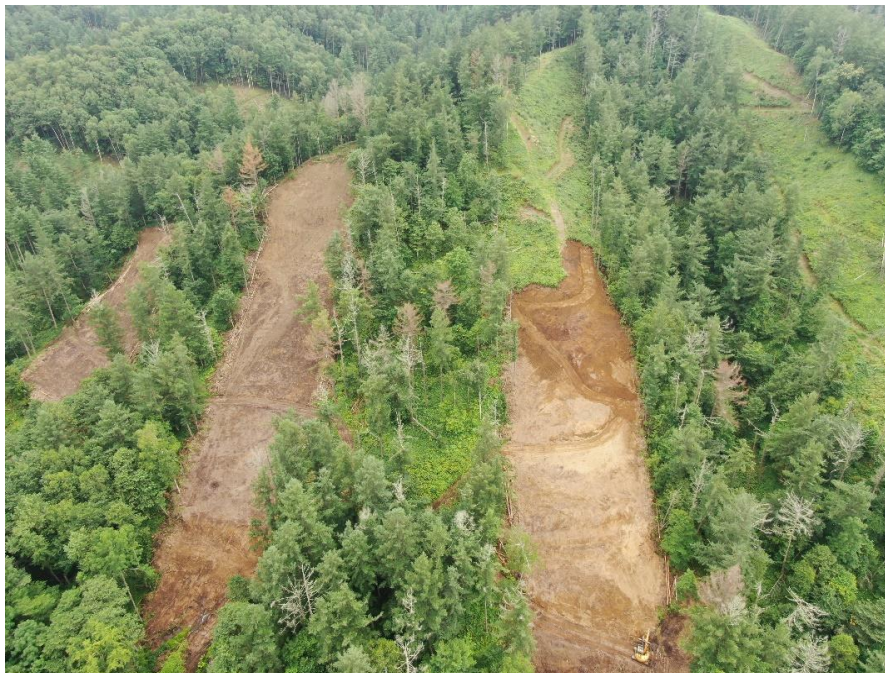
大型機械による地拵作業実施状況
