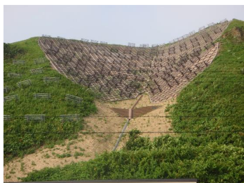
浜中2治山工事（礼文町）
