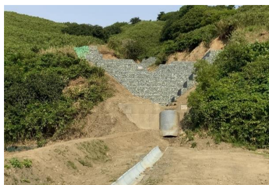
東浦地区2治山工事（稚内市）
