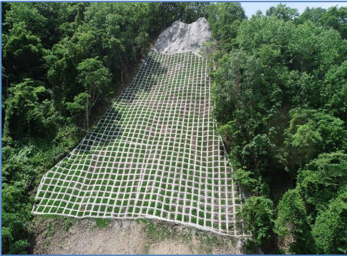
だて 山腹崩壊の拡大を防ぐ簡易法枠工（伊達地区）
