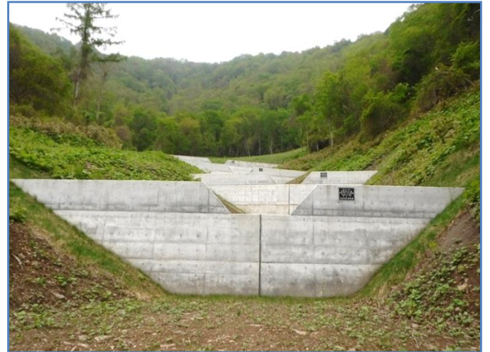
だて 土砂災害を防止する治山ダム（伊達地区）
