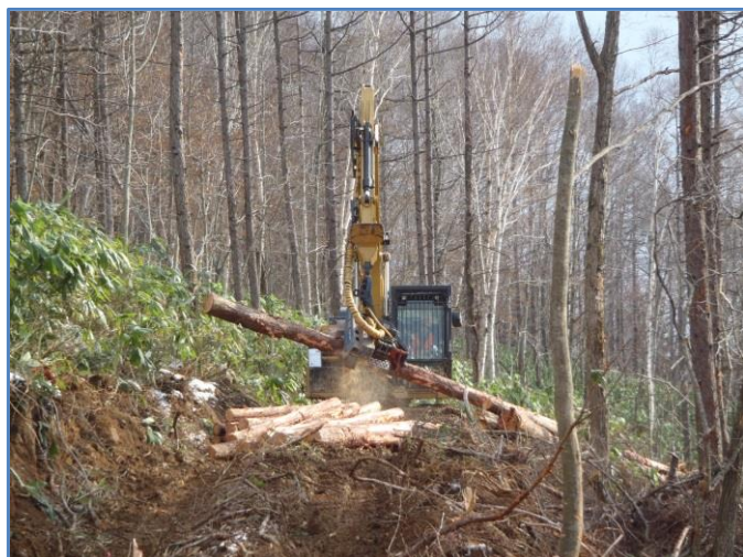
ハーベスタによる伐木造材作業
