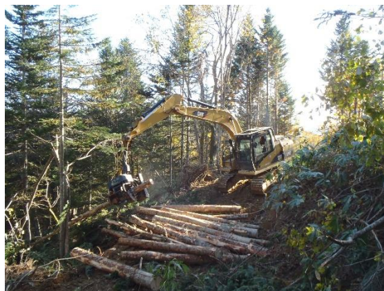
高性能林業機械による間伐
