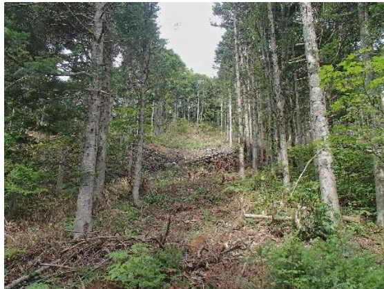
列状間伐実施箇所（留萌市）
