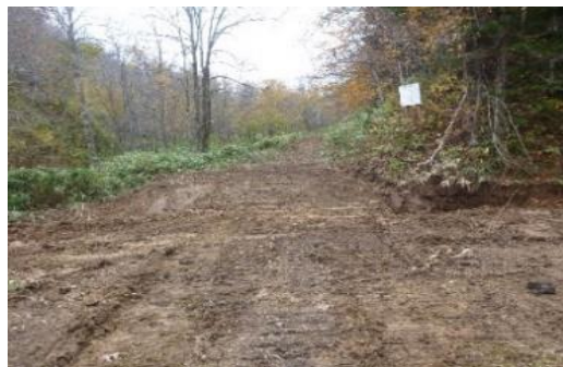
林道修繕箇所(整備後)
