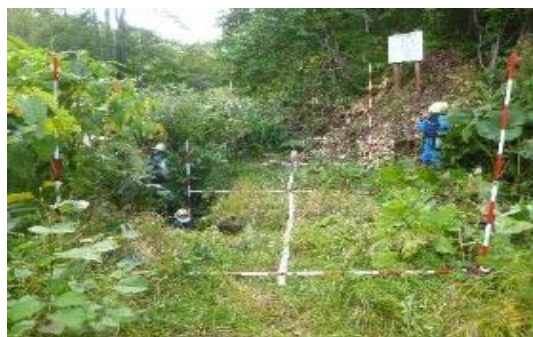
林道修繕箇所(整備前)
