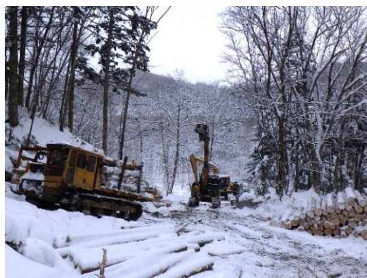
伐採箇所から木材を搬出し、集積している様子
